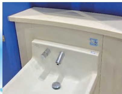
福岡市地下鉄 中洲川端駅
